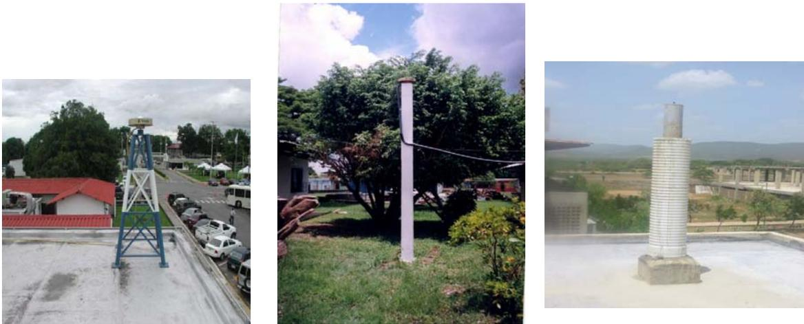
Fig. 2: Tipos de estructuras construidas para las antenas GPS. A la izquierda estación Barinas (metálica), centro estación San Fernando de Apure (concreto armado) y a la derecha la estación Coro (concreto armado).
